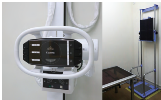
【レントゲン室】
